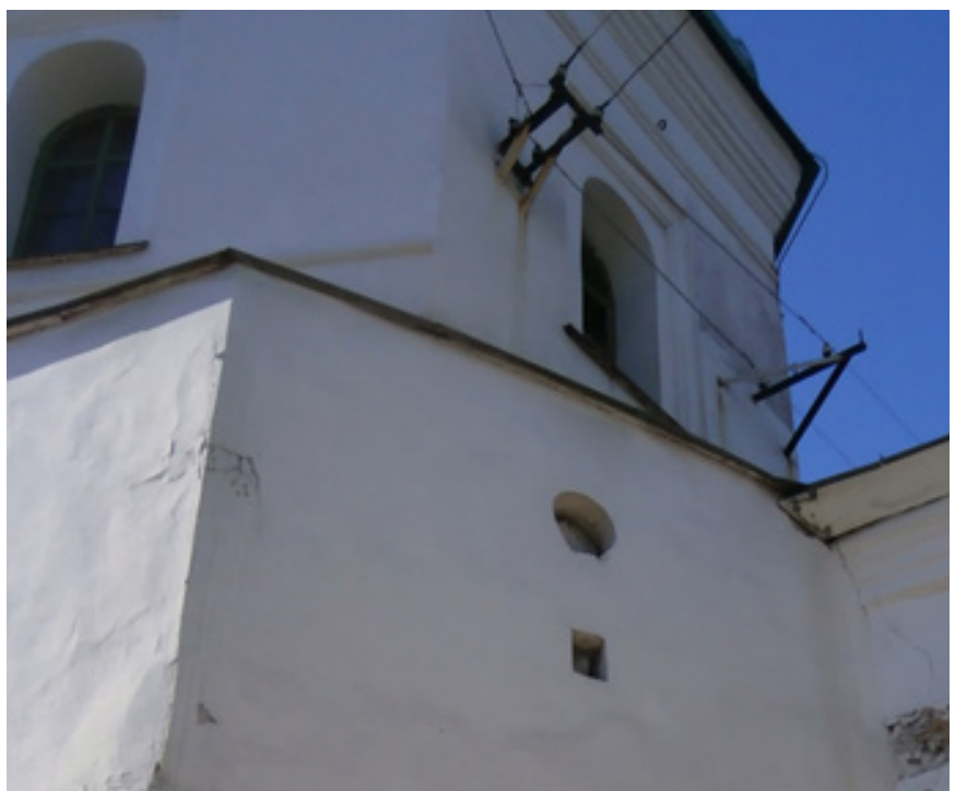
Ил. 23. Фрагмент східної грані фасаду башти Івана Кушника. Над прямокутною бійницею круглий вентиляційний отвір
