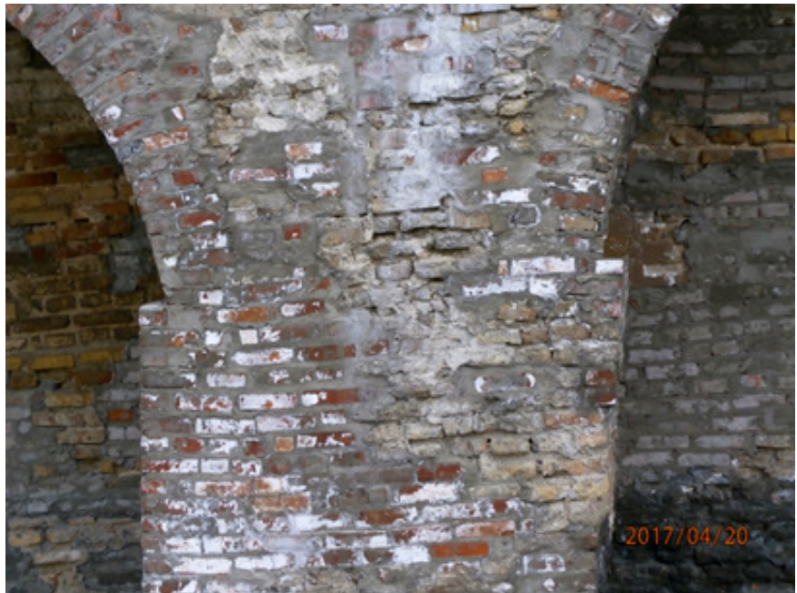
Іл. 40. Фрагмент простінку з полічками для встановлення кружал на ділянці монастирських мурів №2
