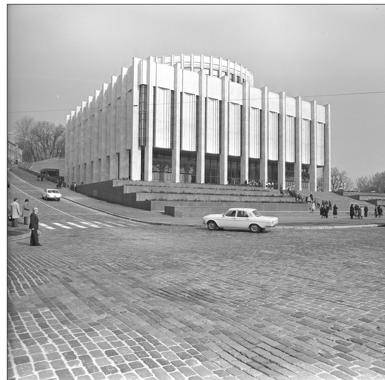
[Будівля Київського філіалу Центрального музею В. І. Леніна невдовзі після відкриття, 1982. Фото Олександра Пермінова]
