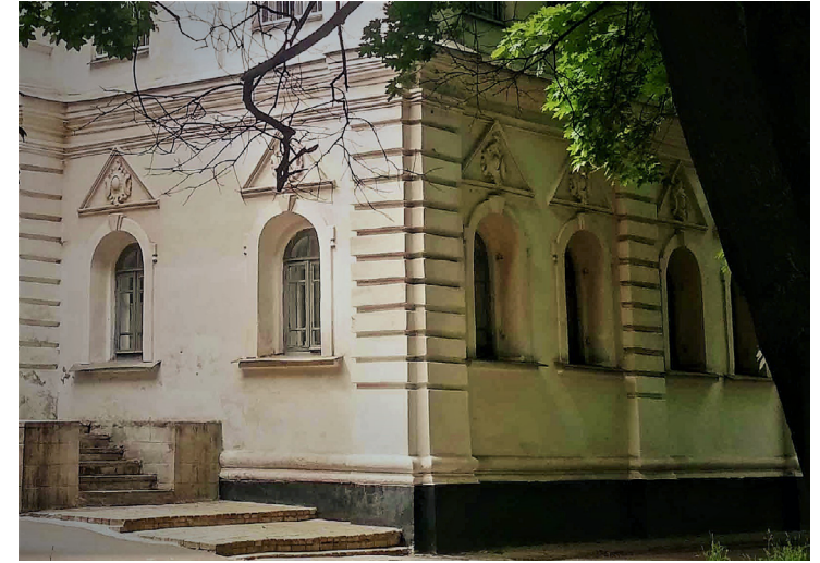
Рис. 22. Будинок канцелярії Київського полку у м. Козельці. 1756–1765 рр. Сучасна світлина
