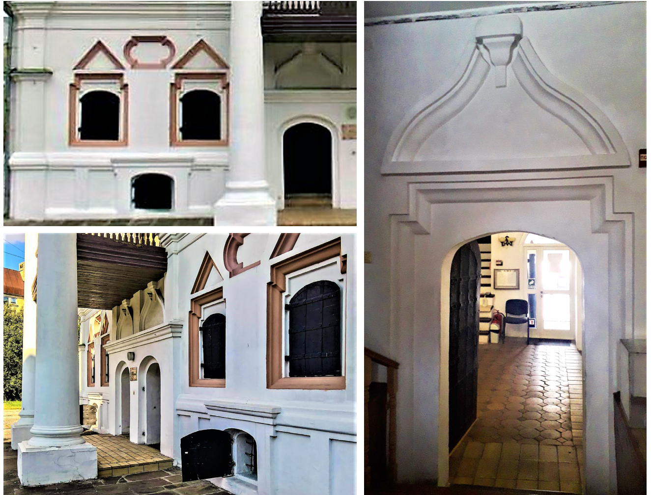
Рис. 3. Будинок по вул. Спаській, 16-Б. Деталі першого поверху
