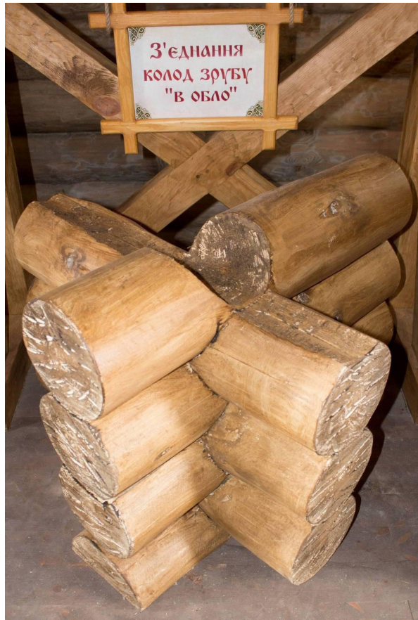
Рис. 25. Макет конструкції зрубу. Метод врубки «в обло». Музей зодчества ПКР
