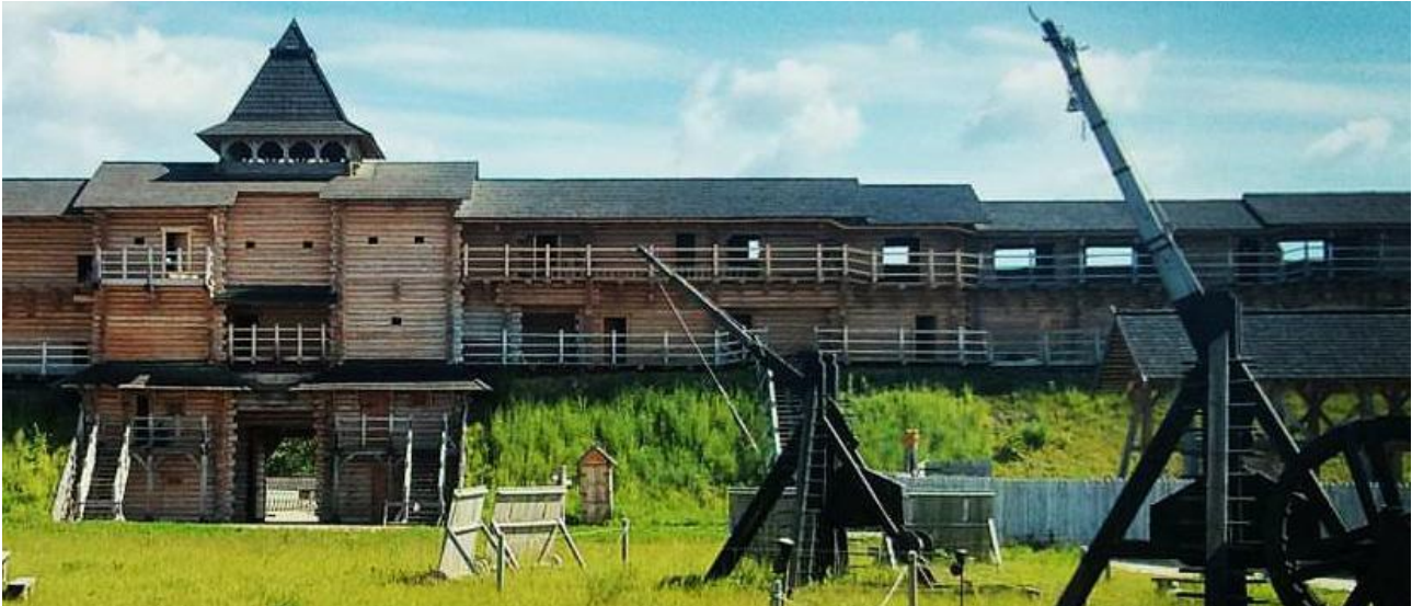
Ил. 20. Парк Киевская Русь. Реконструкция двухъярусного укрепления. Первый ярус – четырехстенные городни. Во втором ярусе чередуются четырехстенные клетки и стенки между ними из горизонтально уложенных бревен. Вид со стороны города. Фото 2016 года.
