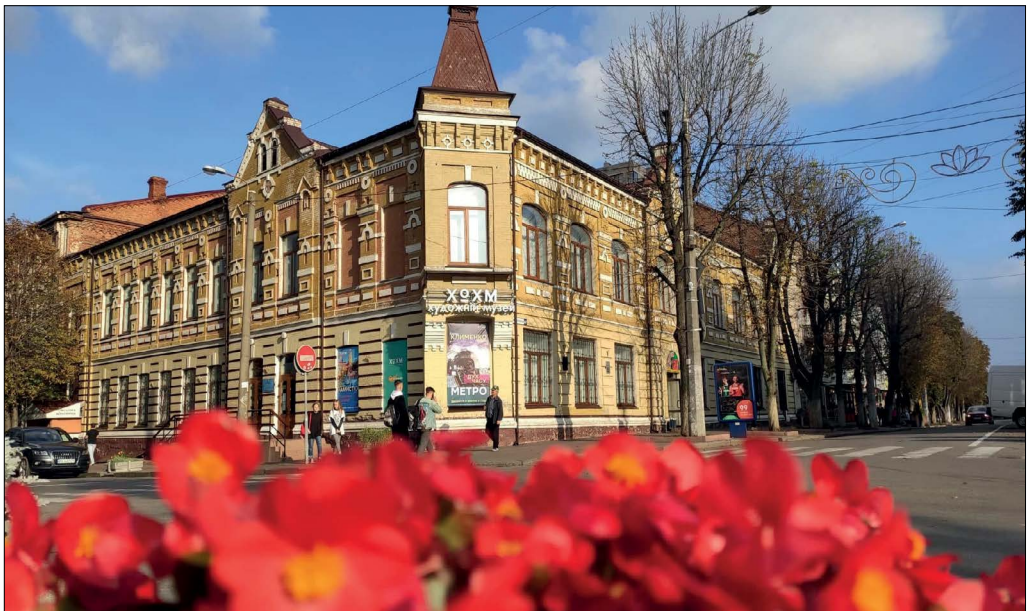
Рис. 12. Фасад ХОХМ, Хмельницький, вул. Проскурівська, 47. 2020
