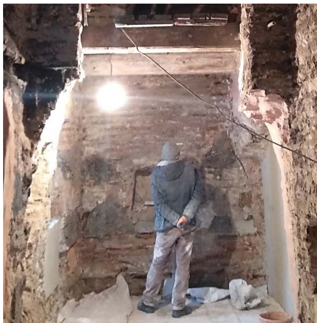
Рис. 12. Південне приміщення першого ярусу Троїцької надбрамної церкви під час проведення ремонтно-реставраційних робіт. Вигляд зі сходу. На південній і північній стінах – зрубані пілястри. Фото 2018 р.
