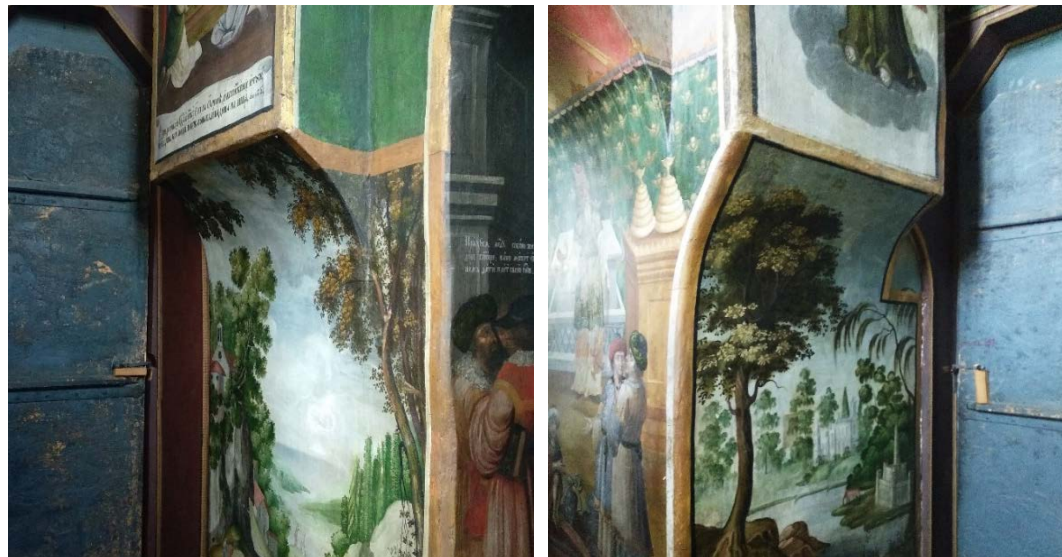
Рис. 24. Залишки початкової підпружної арки. Південна апсида. Вигляд із південно-східного боку (фото 1) дивись маркувальну схему рис.27
