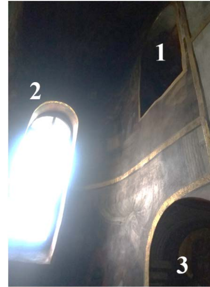
Рис. 30. Північна апсида, вигляд із північно-західного боку (фото 5): 1 – початковий віконний проріз; 2 – наявний віконний проріз; 3 – проріз для проходу між північною і центральною апсидами (фото 5)
