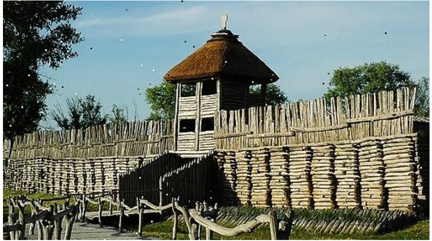
Ил. 17. Реконструкция простой деревоземляной стены из городен, которые забучены землей без обвалования. Вид со стороны поля. Польша. г. Бискубин.
